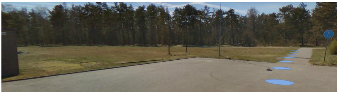
Vändplats med nätstation till vänster och gång- cykelbana till höger i bild.
