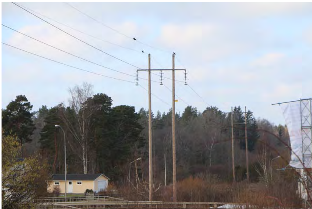
Figur 1. Bild på en träportalstolpe. Tre faslinor hänger från isolatorerna under den tvärgående regeln.
