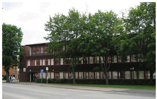
Bild 5. Polishuset, fasad mot Arvidstorpsvägen.
