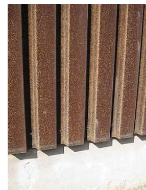
Bild 7,8. Gavel mot Ringvägen och närbild cortenplåt.
