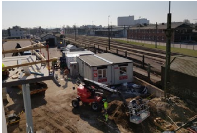
Spårområdet utgör en olycklig barriär i staden. Fastighetsägare vill bygga bostäder i området, men det är komplext och kostsamt att ta bort industrispåren som fortfarande används.
