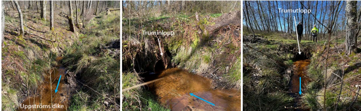
Figur 12. Diket (C) inom samfällighet Vesslunda s:6. Blå pilar visar flödesriktning i diket. Foton tagna under platsbesök 100424.
