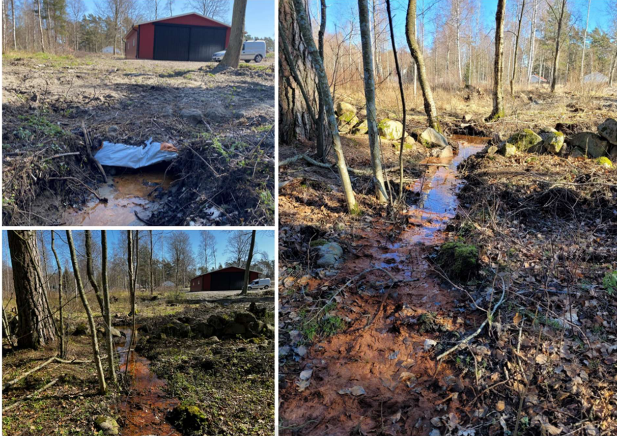
Figur 11. Utlopp från stenkista och mindre dike (A) tillhörande ekonomibyggnad på fastighet Vesslunda 1:7. Foton tagna under platsbesök 100424.
