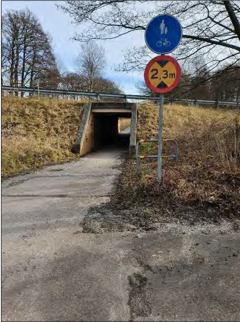
Figur 9. Lågpunkt längs Elvägen, nedanför väg N767, med risk för översvämning
