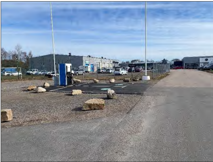
Figur 10. Laddstation för elbilar norr om planområdet.
