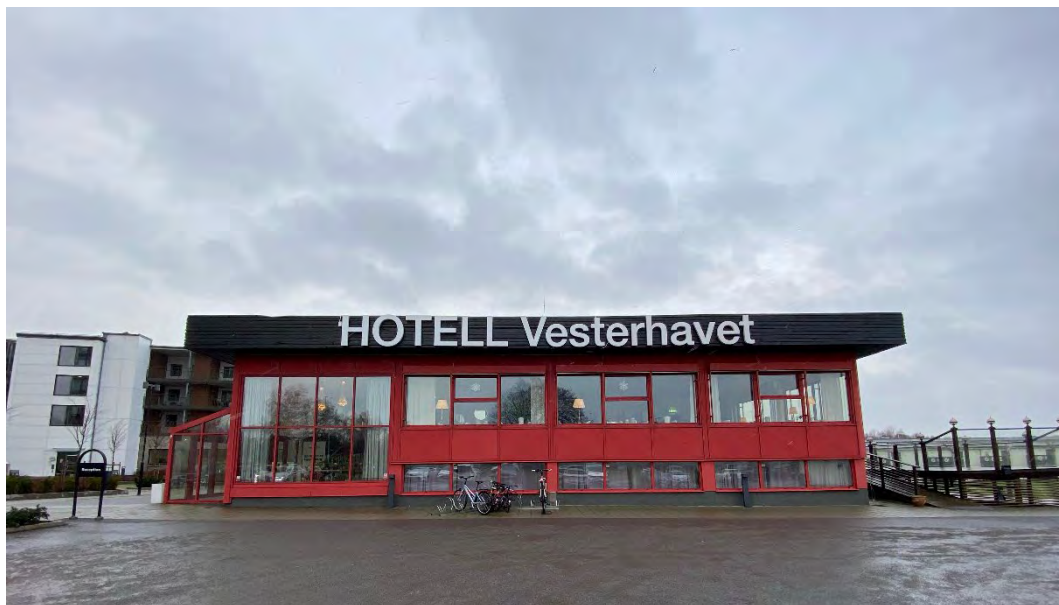
Figur 4 Befintlig hotellbyggnads södra fasad.
