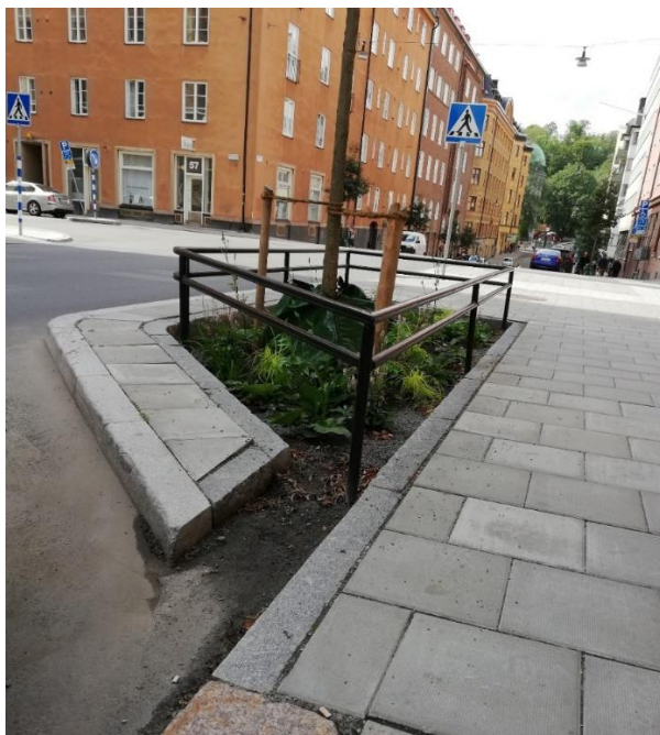
Figur 31 Växtbädd i kombination med refug med öppning för inflöde av vatten. (Foto: Kristina Lundgren, COWI).
