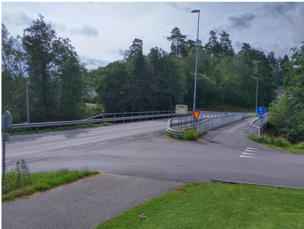
Figur 5. Angöring från väg 154 in på Kyrkovägen.
