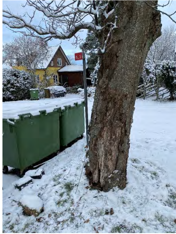
Figur 23. Omfattande stam- och stambasskada på träd nr 10.
