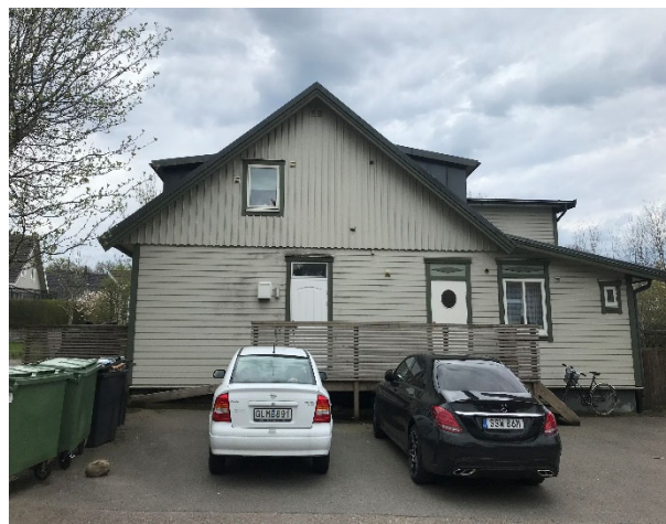
Befintligt bostadshus, vy från norr, Skärslidarna
