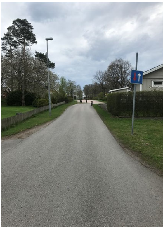
Erik Falks väg från Skärslidarna i riktning söderut mot Karl Salomonssons väg. Erik Falks väg föreslås planläggas som GATA med infart till fastigheterna Tröinge 6:45 och Tröinge 14:2
