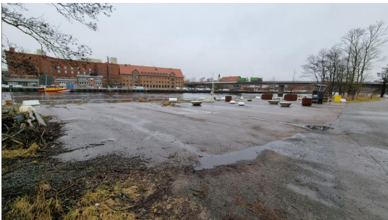
Figur 4.5. Lekplats inom utfylld spontkaj.
