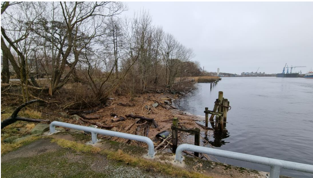
Figur 5.3. Område närmast söder om spontkajen som saknar erosionsskydd.
