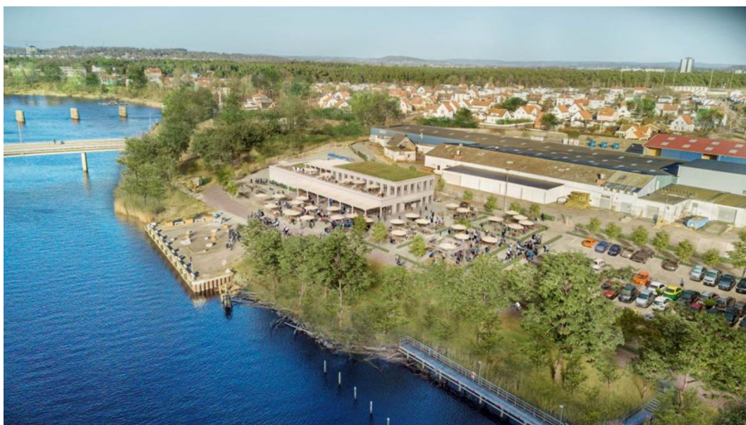
Figur 12 Fotomontage över en möjlig utformning av byggnaden och området från samrådsskedet, Sköld Forsberg, 2022-10-13.
