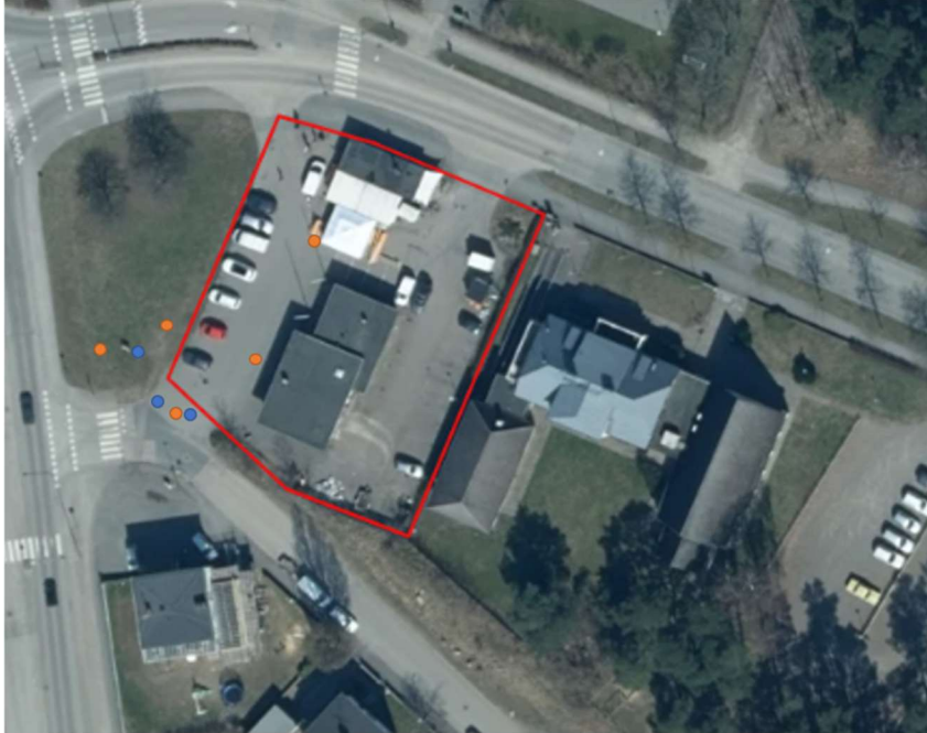
Figur 4. Markföroreningar inom planområdet. Blå markeringar visar kvarlämnade föroreningar, orangea markeringar visar sanerade punkter. Markeringarnas placering är tolkad utifrån tidigare undersökningar. Ungefärlig fastighetsgräns för Spetsen 1 är markerad med röd linje. (Afy, 2022b)
