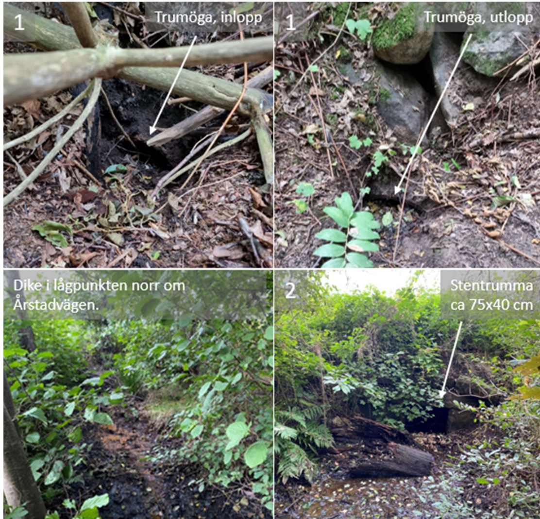
Figur 9. Foton för trummor och dike tagna vid platsbesök september 2023.
