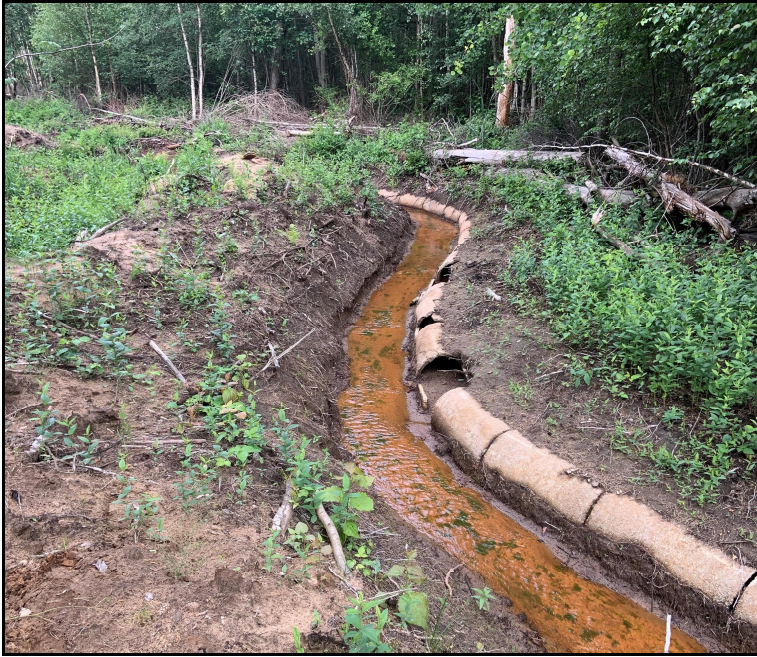
Foto 1. Till höger i bild ses den äldre kulverteringen av Kvicksandsbäcken och till vänster den nya tillfälliga bäckfåran.
