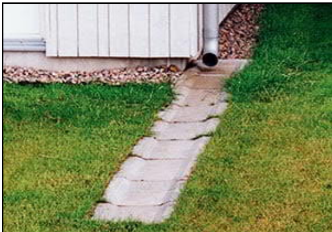
Foto 4. Utkastare med rännalsplattor för att leda vattnet bort från huset (Svenskt vatten).
