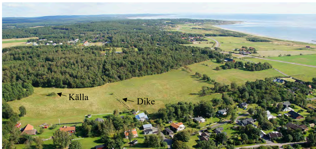
Figur 8. Flygfoto från 2009 fotat från nordväst och som illustrerar placering av dike innan arkeologisk utgrävning påbörjades samt illustrerar plats för naturlig källa.
