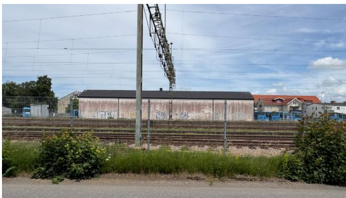
Figur 12. Servicebyggnad inom busstation
