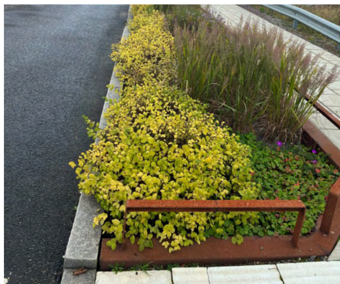
Smalare växtbädd för infiltration
