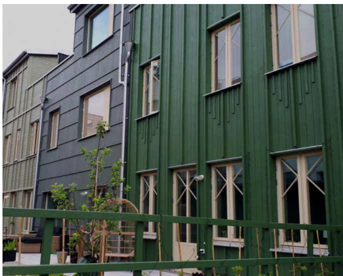
Radhus i enhetligt material med variation i fasaduttryck
