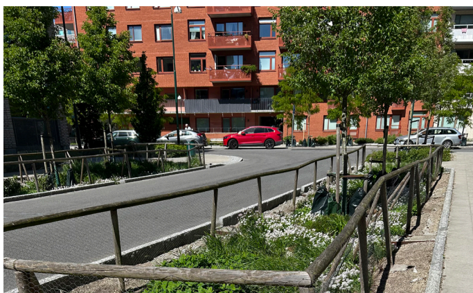
Växtbädd för infiltration mellan kör- och gångbana
