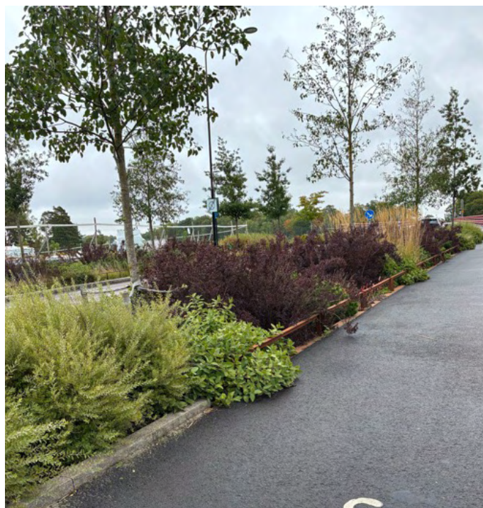
Växtbädd för infiltration med mindre träd
