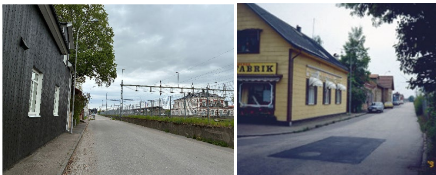
Bild på Rampen 18 efter renovering. Bild innan renovering Källa: Falkenbergs arkiv 1991
