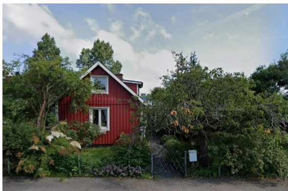
Bild på Rampen 19
