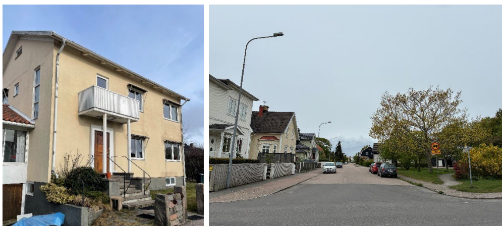
Bilder visar bostadsbyggnad på Rampen 19 och bostadsbyggnader utmed Porsevägen (i öster).
