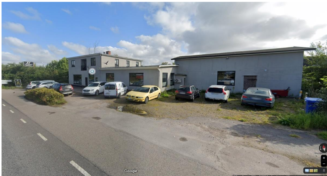
Figur 2: Bild över Morup 6:11 idag. Idag bedrivs en verkstad på fastigheten samt en lägenhet ovanpå denna verkstad. Det enda som kan urskiljas från den gamla bensinstationen är refugen som idag är bevuxen av buskar.
