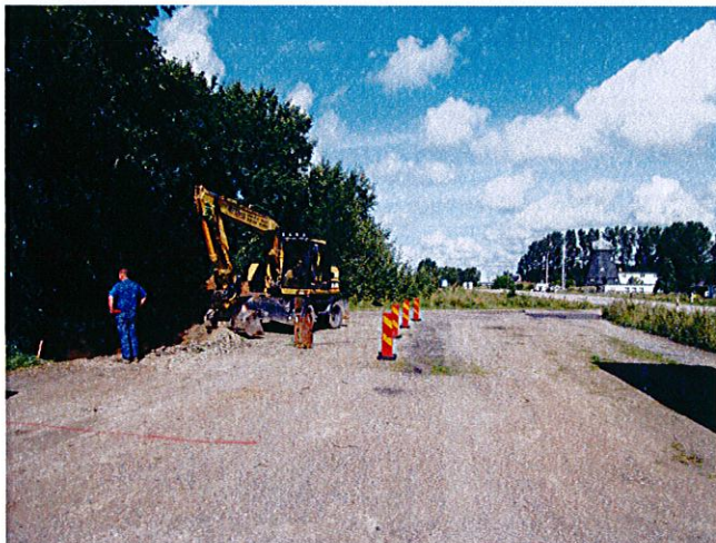
Bild 1. Cisternerna grävs fram.
