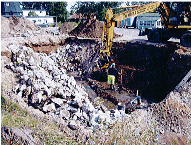
Bild 3. Betongfundamenten har krossats och användes delvis senare vid återfyllningen.
