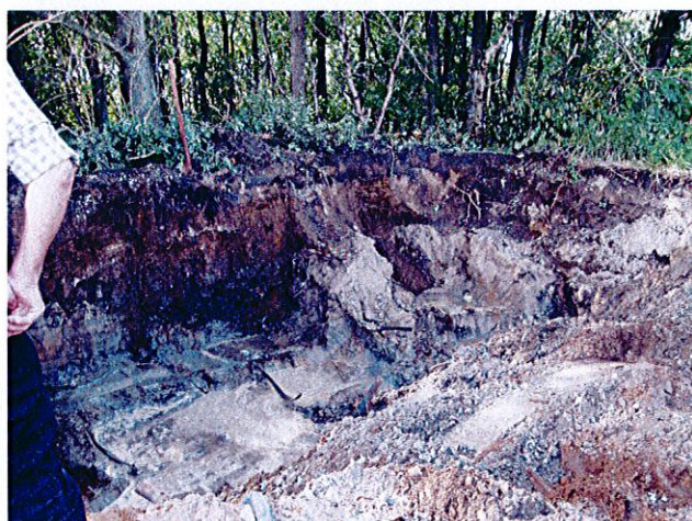
Bild 4. Den förorenade jorden kring cisternerna grävs bort.
