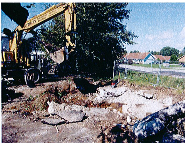
Bild 5. Bortgrävning av förorenad jord vid betongplattan där dieselcisternen har varit uppställd.
