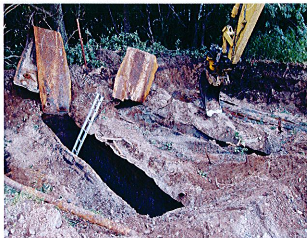
Bild 2. Cisternerna grävs ur och rengörs av EkoTec och Slamsugningstjänst i Halmstad.
