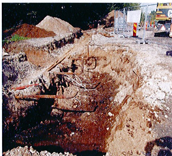
Bild 5. Pumpön har legat mitt i gropen . sugledningarna som står upp (3 st) har varit anslutna till pumparna.
