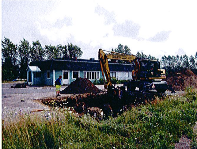
Bild 1. Förorenad jord vid den gamla cisternschakten grävs bort.
