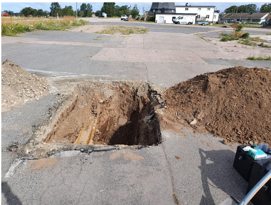
Figur 5. Äldre rörledningar i provpunkt 20AF07. Bildkälla: AFRY 2020-07-21.
