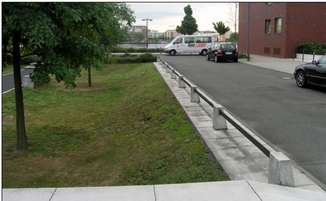
Figur 12. Exempel på svackdike (Foto: WRS).
