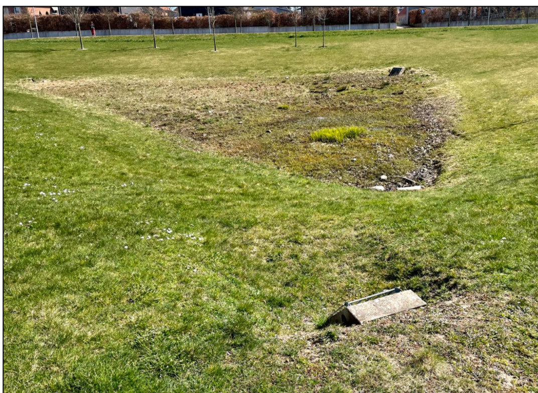
Figur 17. Torr damm med bräddavlopp. Dalby, Skåne.
