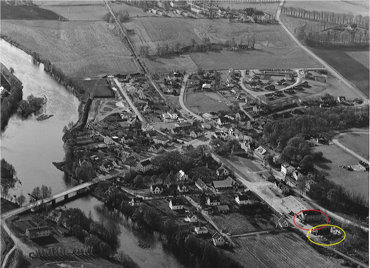
Flygfoto från 1970 när Lantmannaföreningen flyttat sin verksamhet till platsen norr om stationen. Här syns KG:s magasin (gul ring) i och Lantmannaföreningens magasin från 1930-talet (röd ring) med den nybyggda hallen sammanbyggda i söder. Foto: Vessige-Alfshögs hembygdsförening
