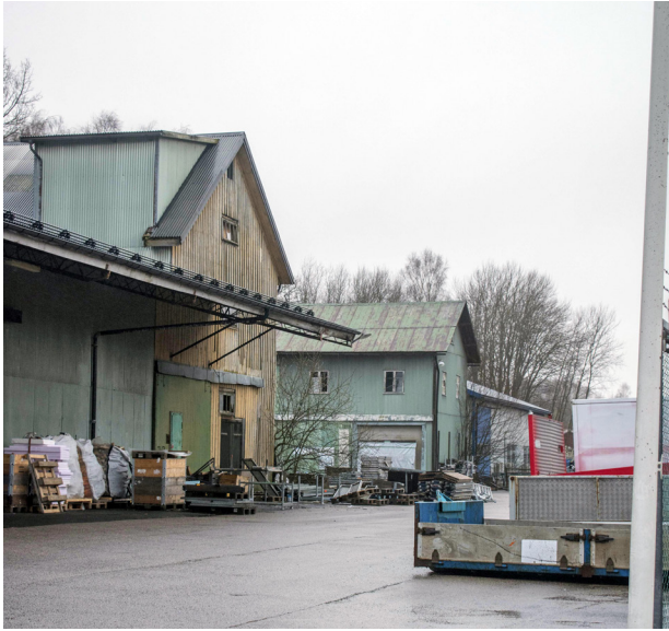
I förgrunden syns östra gaveln på det södra magasinet och i bakgrunden det norra magasinet.
