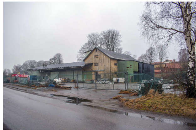
Det södra magasinet byggdes till med en stor hall år 1966.
