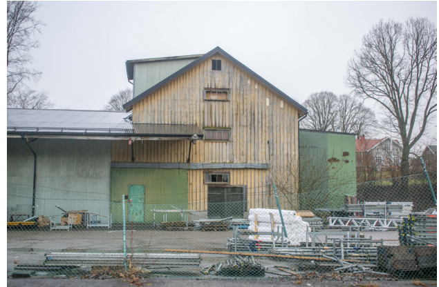
På den östra gaveln är den äldre träpanelen bevarad. Fönstren tycks bevarade sedan 1930-talet.
