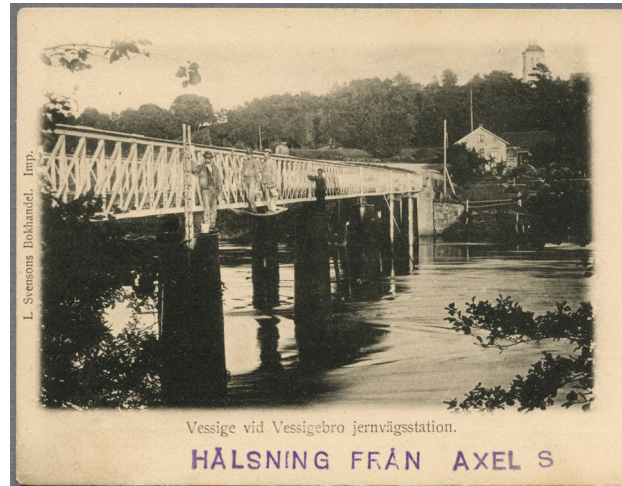
Vykort från ca 1910 med bron över Ätran. I bakgrunden skymtar tornet på Vessige kyrka. Foto: Järnvägmuseet.
