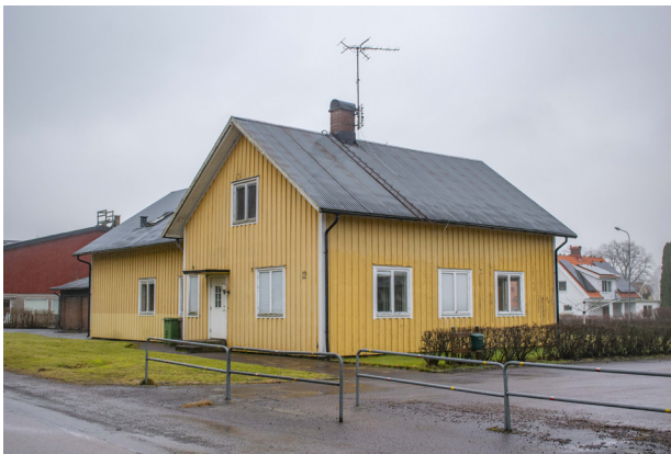
Järnvägsstationen, och den tillbyggda delen från 1908, sedd från Stationsgatan. I bakgrunden skymtar f.d. lantmannaföreningen/Vessige byggmarknad.
