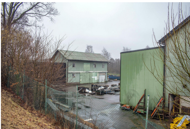
På den södra sidan finns stora skjutportar. I förgrunden syns den tillbyggda lutan i plåt på det södra magasinet.
