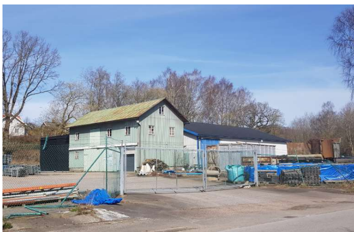
Befintlig bebyggelse på 3:81 och 3:171
