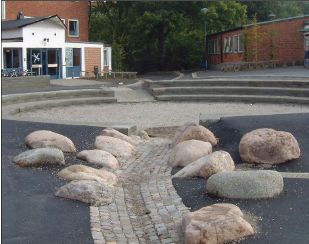
Figur 26. Skolgård med översvämningsyta i form av nersänkt lekyta. Augustenborgsskolan, Malmö.
