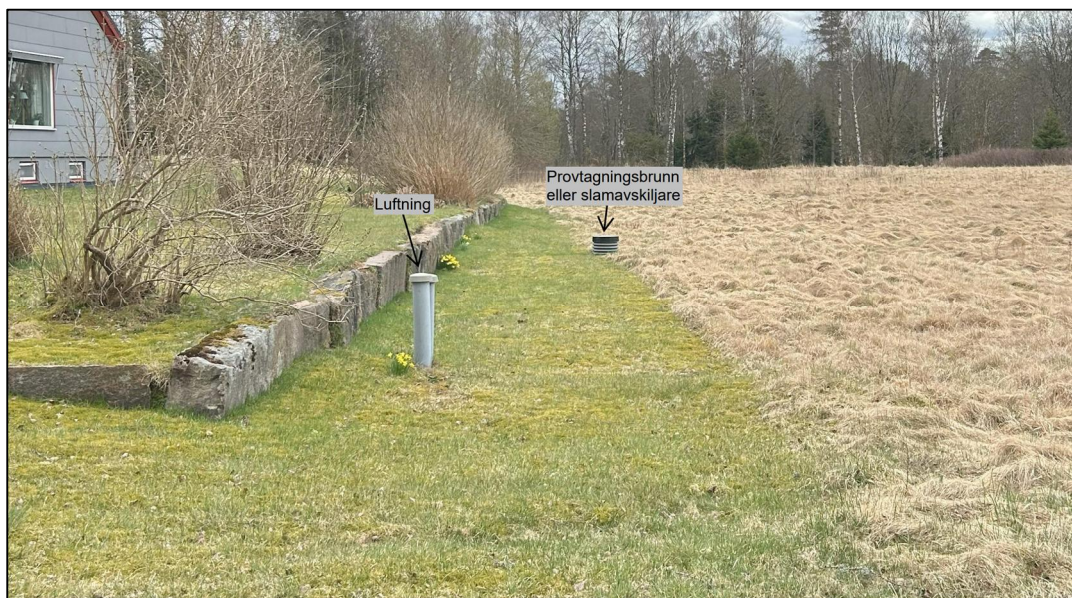
Figur 7. Trolig infiltrationsbädd (avloppsanläggning) i anslutning till delområde B.
