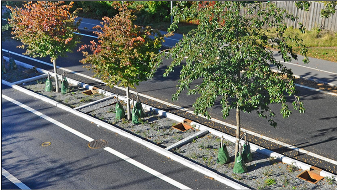
Figur 22. Exempel på utformning av växtbäddar med trädplantering (Bildkälla: Stockholms stad).
