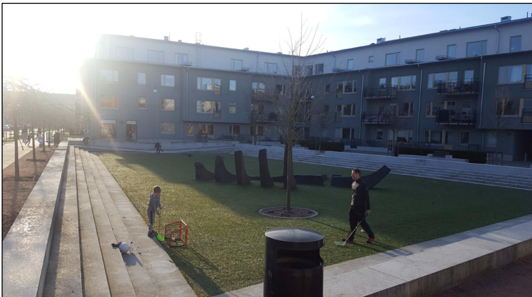
Figur 27. Översvämningsyta i form av nersänkt lekplats. Malös gata, Göteborg.
