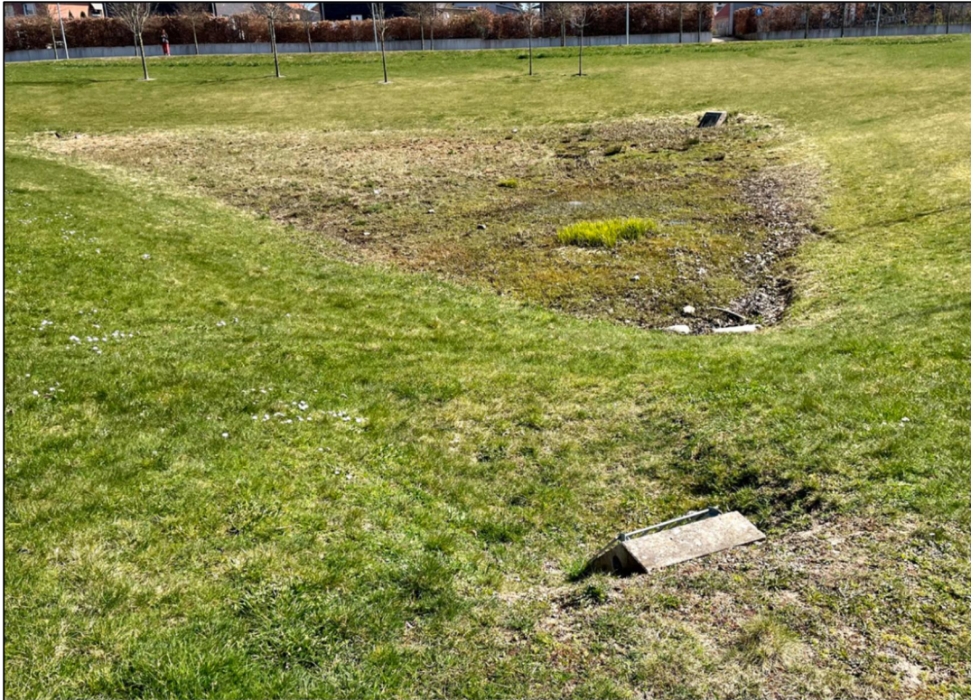
Figur 28. Torr damm med bräddavlopp. Dalby, Skåne.
