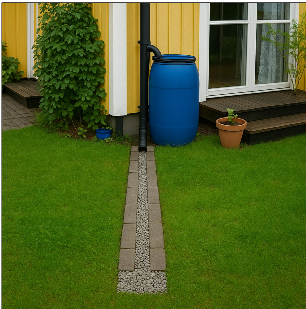
Figur 25. Illustration för stuprör med ränna och regntunna.
