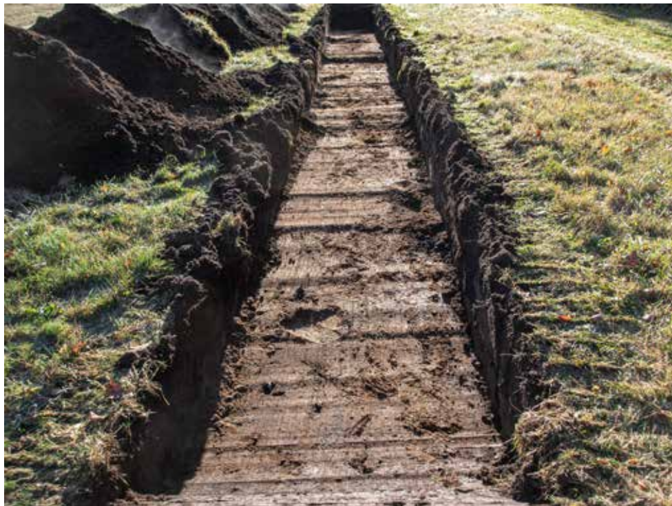
Figur 5. Schakt 239. Mot S. Foto: Jonas Carlsson. (Fotonr. 2022-00098-5).
