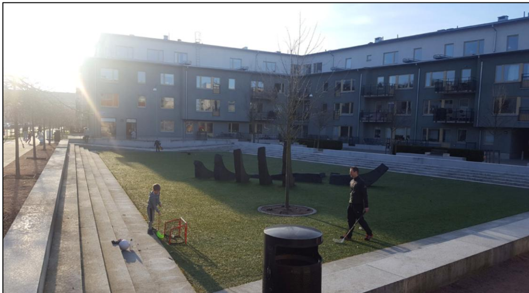
Figur 15. Översvämningssyta i form av nersänkt lekplats. Malös gata, Göteborg.
