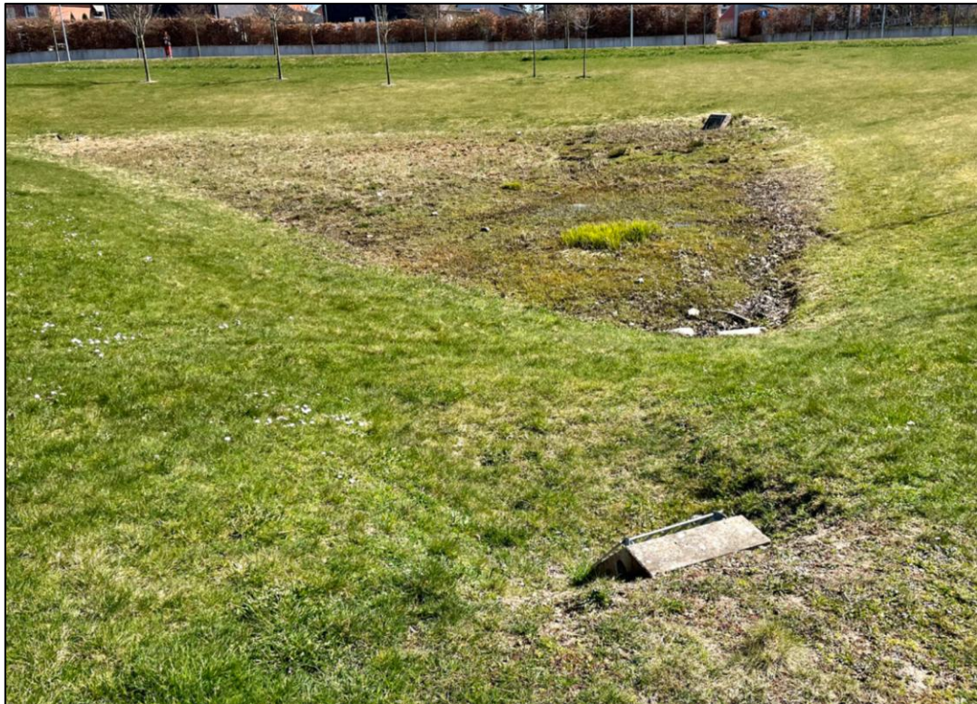
Figur 16. Torr damm med bräddavlopp. Dalby, Skåne.
