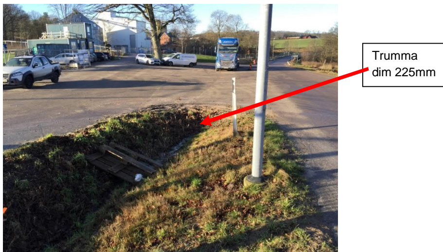
Figur 21. Dike mellan verksamhetsytan och Toarpsvägen med trumma under infart. Bild tagen 2020.
