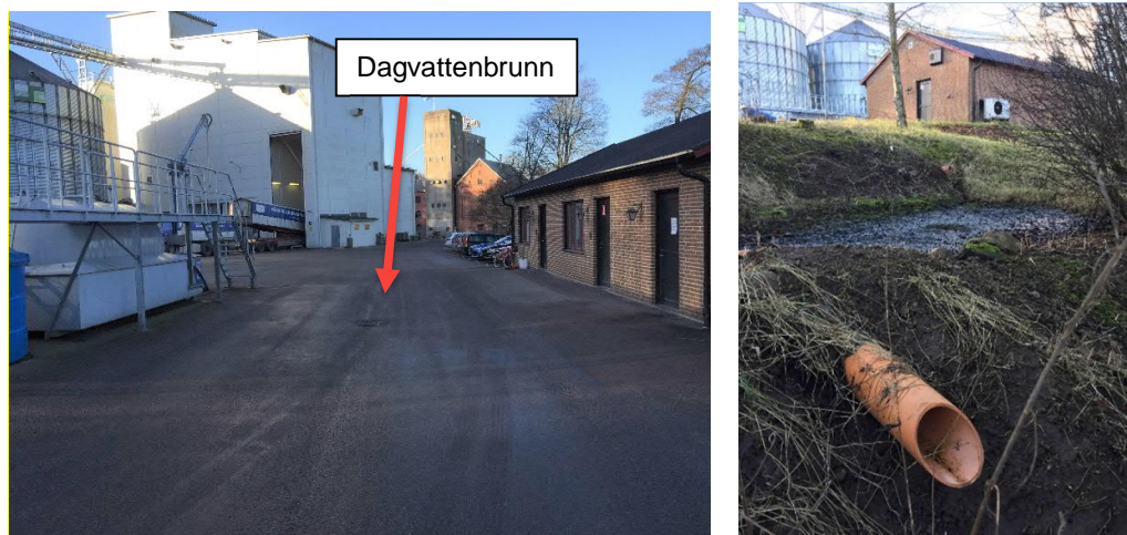
Figur 3. Delområde 2: Till vänster – tidigare spolplats med dagvattenbrunn. Till höger – övre mindre damm samt utloppsledning till nedre damm.
