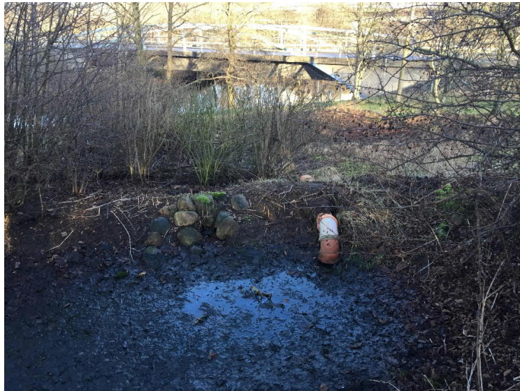
Figur 4. Övre damm med koppling till nedre damm. I bakgrunden Toarpsvägens bro över Suseån.
