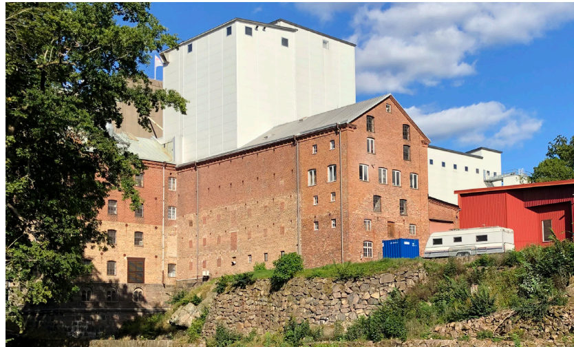
Det stora magasinet som delvis är ombyggt till renseri.
