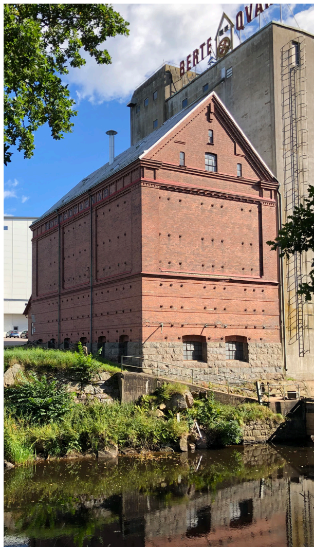
T.v: Magasinet sett från nordväst. Här syns de runda ankarlut som bär upp spannmålsbehållare inuti byggnaden.
