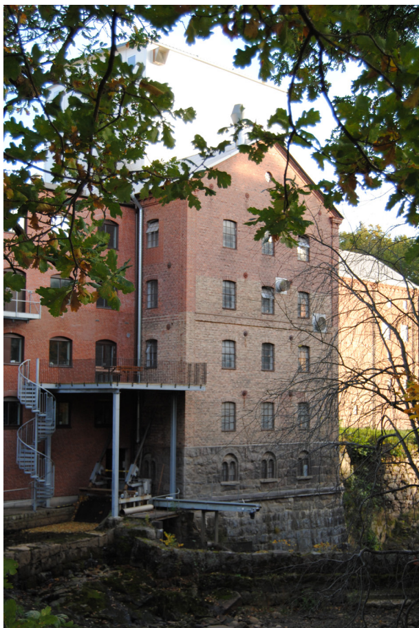
Kvarnen sedd från andra sidan Suseån. De nedre våningarna utgör den äldsta delen av byggnaden. Skiftningarna i teglets kulör berättar om de olika tillbyggnadsetapperna.
