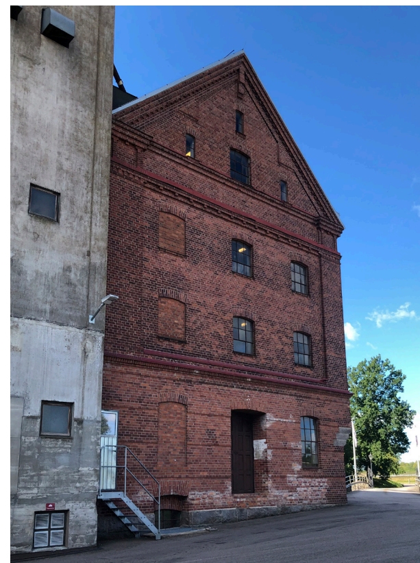
T.v: Magasinet sett från nordväst. Här syns de runda ankarlut som bär upp spannmålsbehållare inuti byggnaden.
