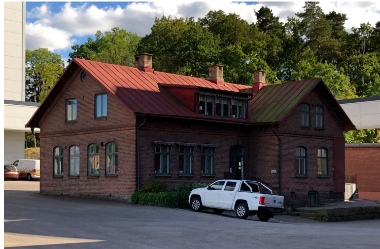
T.v: Kontoret från nordväst. Här syns huvudentrén och stenterassen.
