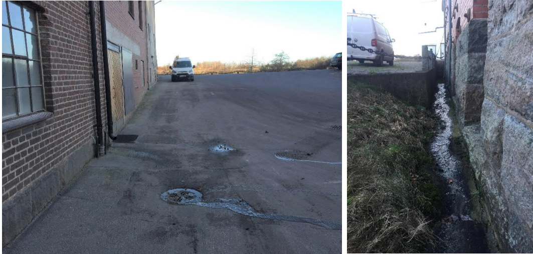
Figur 5. Dagvattenbrunn vid äldre byggnad i västra delen. Till höger - Ytlig avledning från stuprör.
