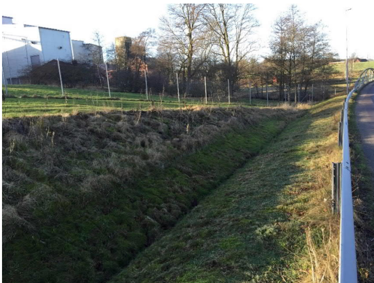
Figur 7. Vägdike vid Toarpsvägen som mynnar i Suseån.
