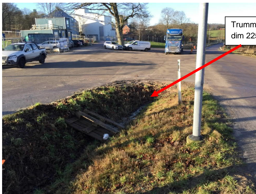
Figur 18. Dike mellan verksamhetsytan och Toarpsvägen med trumma under infart. Bild tagen 2020.
