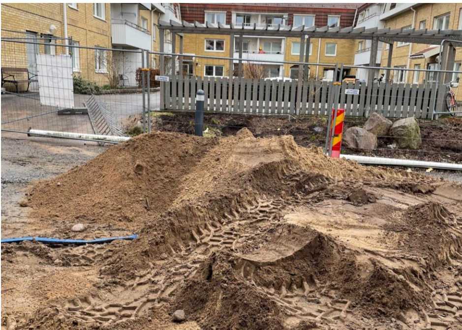
Figur 5. Uppschaktat material från området kring provpunkt TR1. Bild mot norr
