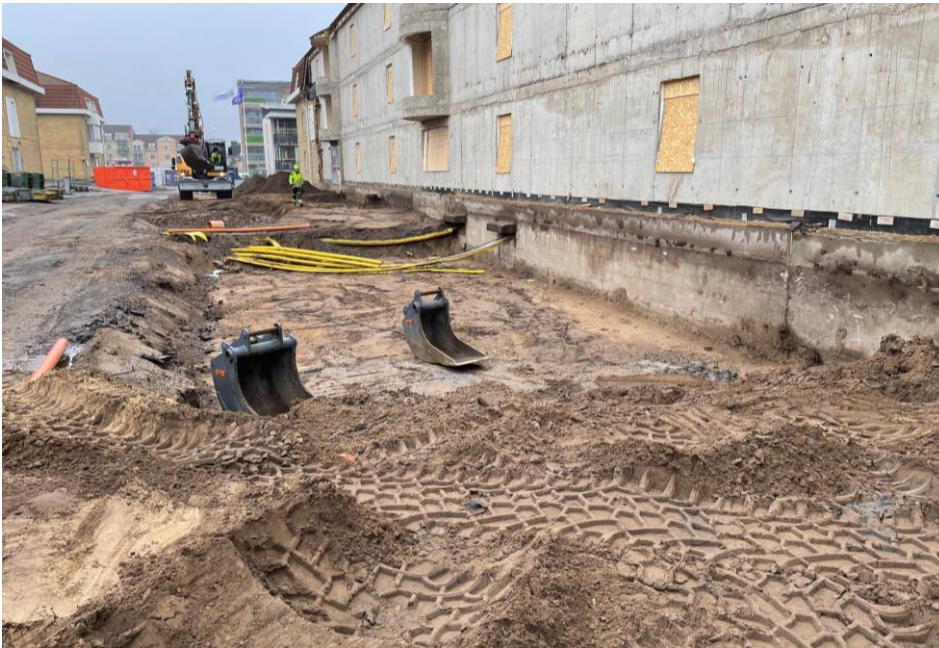
Figur 4. Schakt vid provpunkt TR6. Bild mot öst
