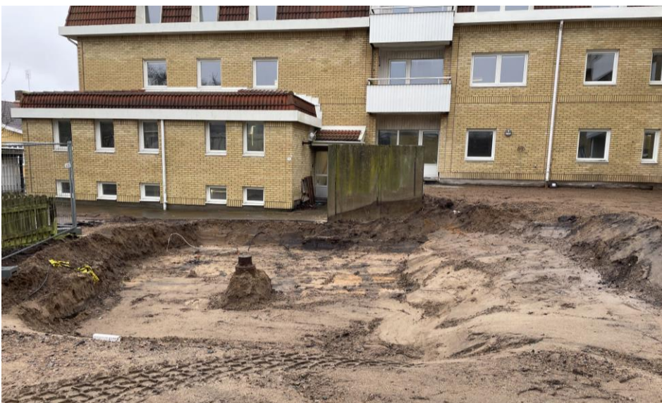
Figur 3. Schakt vid AFRYs tidigare utförda provpunkt 22AF08 där halter av PAH påträffats. Bild mot väst
