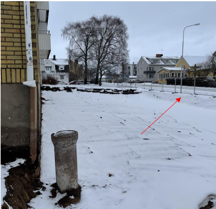
Figur 2. Avhjälpandeåtgärd vid 21AF01. Kvarlämnad förorening återfinns i östra schaktväggen, se röd pil
