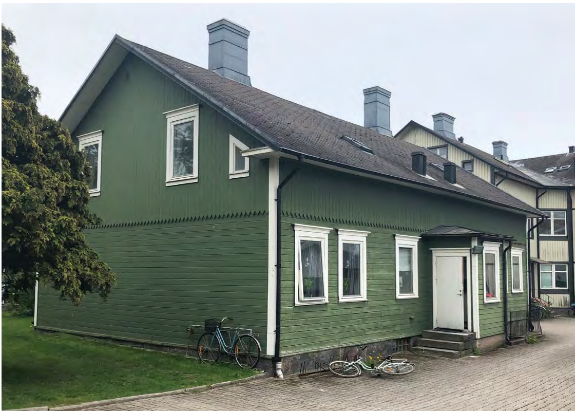
Bild på existerande gårdshus. Foto från kulturmiljöutredningen av Kulturmiljö Halland.
