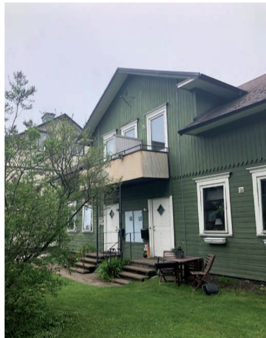
Byggnadens östra fasad med två entréer samt en funktionalistiskt präglad balkong som tillkommit senare.
