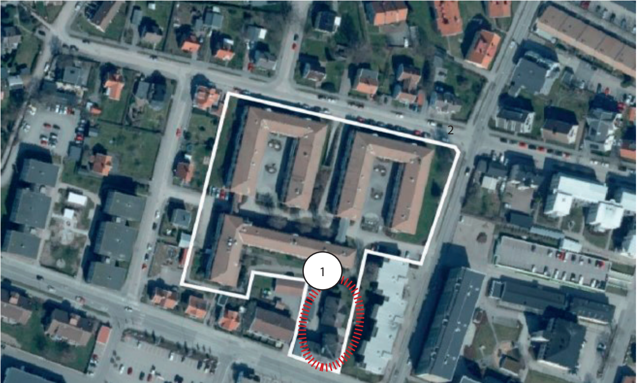
Översiktsbild över planområdet. Nr 1 markerar de två byggnaderna i kv Trädgården 8 som pekats ut som kulturhistoriskt värdefulla i bebyggelseinventeringen 2006.
