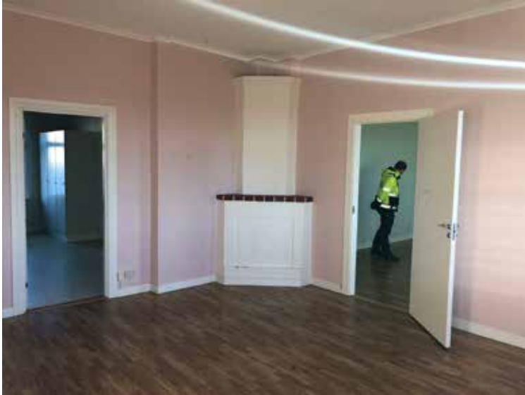
Igensatt edstad i rum mot gatan. Troligen har här tidigare stått en kakelugn.
