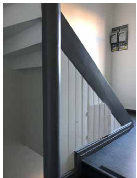
Parti med pärlspontpanel med tillhörande förrådslucka mellan våningsplanen.
