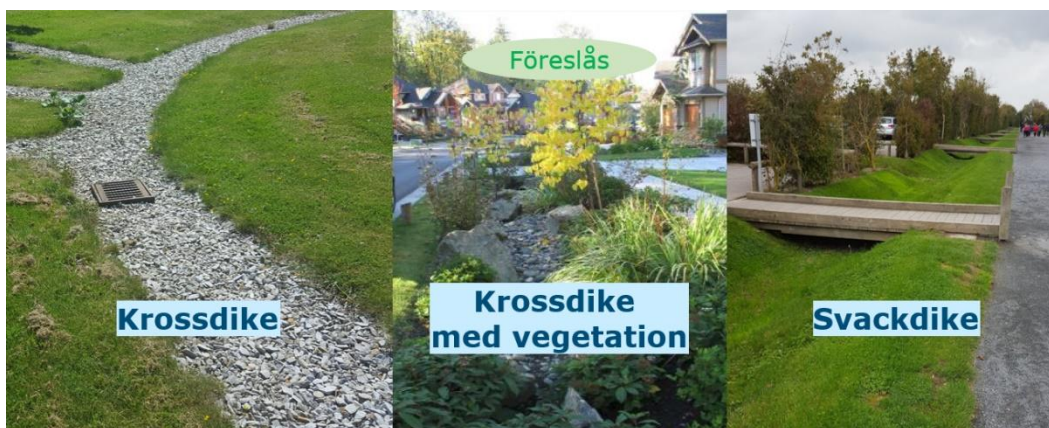
Figur 16 Exempel på anlagda kross- och svackdiken (Bilder: t.v. Axel Sahlin, 2016, mitten Ramboll, 2012, t.h. Mikaela Rudling, 2015)
