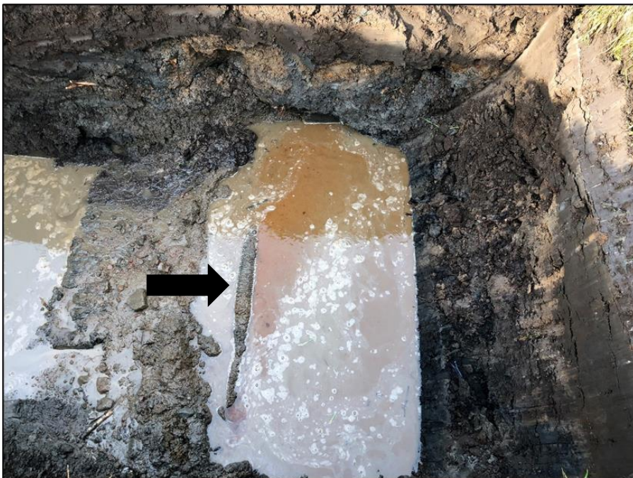
Figur 19. Dräneringsledning i provpunkt 21AF10. Foto: AFRY.
