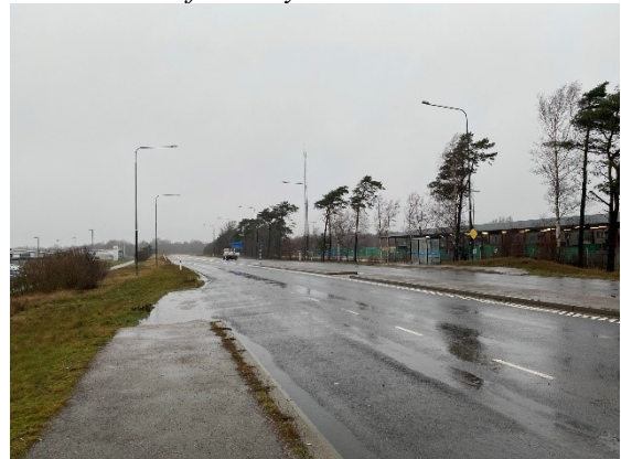
Väg 767 med riktning västerut.
