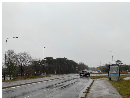
Busshållplats längs med väg 767. Sett från väg 767 i östlig riktning.
