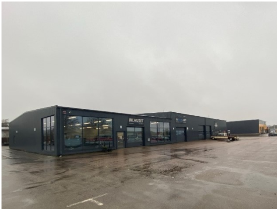
Bilhuset. Sett från Oktanvägen.
