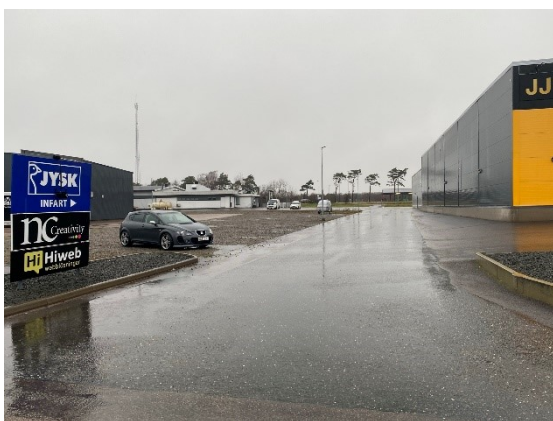
Dricks- och spillvattenledningar är placerade väster om infart till Jysk. Sett från Oktanvägen.
