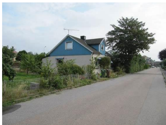
Bild 10. Byggnad längs Brückeavägen, inom Dikaren 12, vilken avses rivas.
